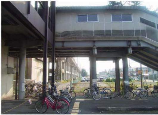
現場全景(北東→南西)
