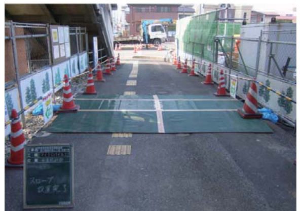
スロープ設置
