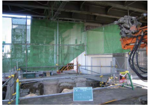
飛散養生(メッシュシート)
