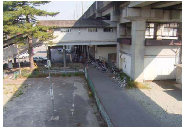
現場全景(南西→北東)
