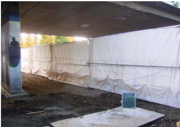
道路側飛散防止(シートフェンス)
