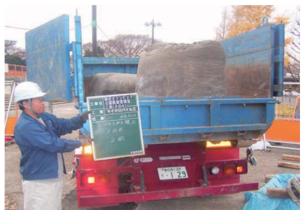
産廃処理(グラウト残塊)
