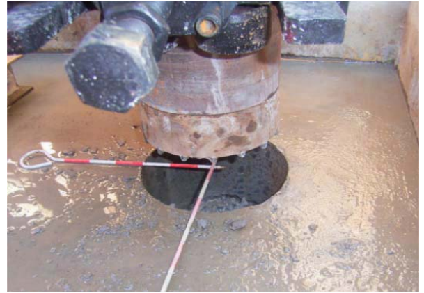
削孔位置確認
