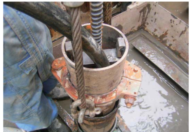
鋼管保持およびグラウト注入状況
