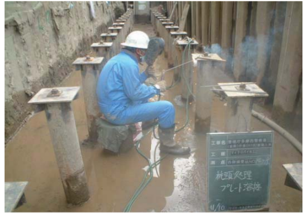
杭頭処理状況
