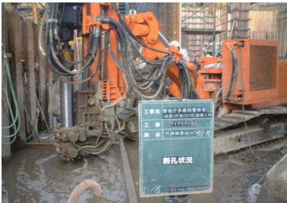
ケーシング削孔状況
