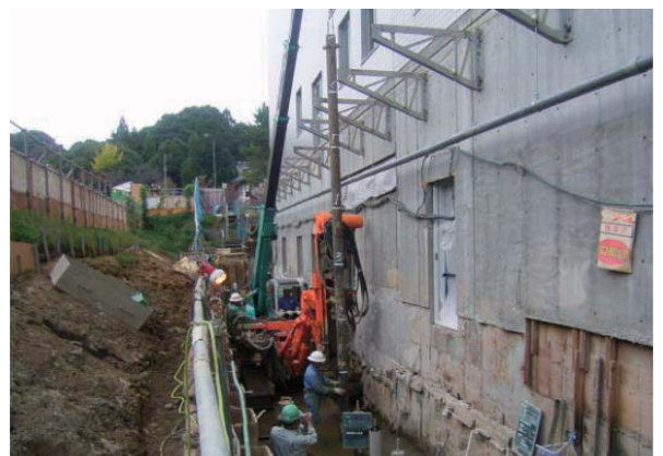
鋼管建込み状況
