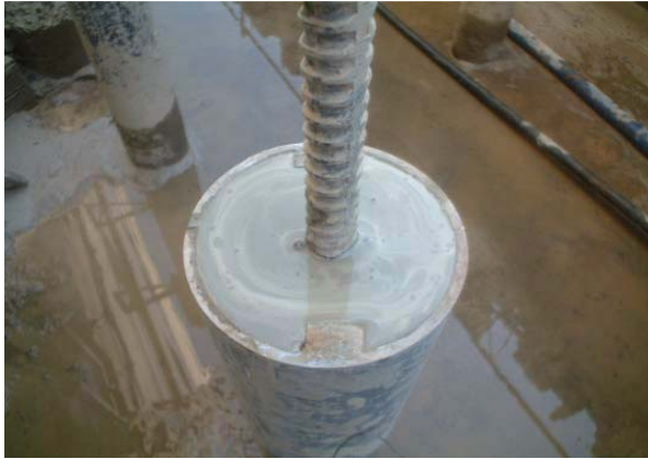
グラウト注入完了
