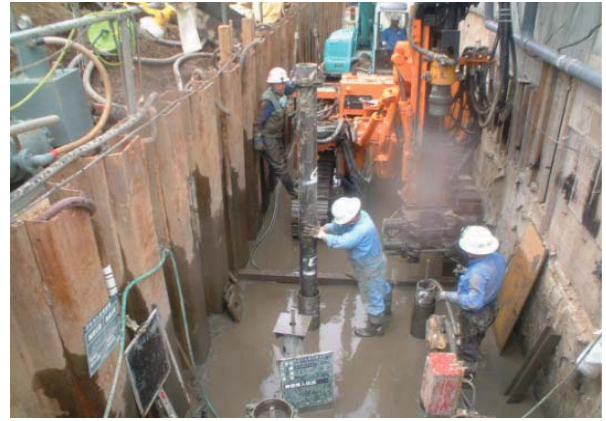
鋼管挿入状況
