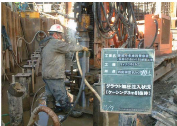
グラウトケーシング加圧注入状況
