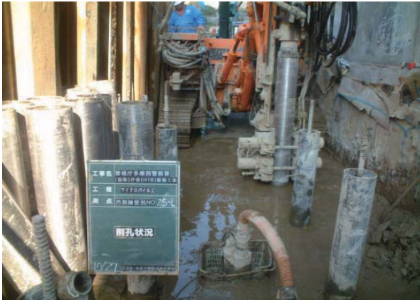
ケーシング削孔状況
