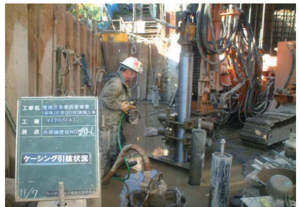
ケーシング引抜き状況
