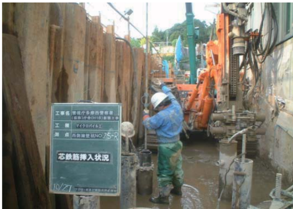
芯鉄筋挿入状況
