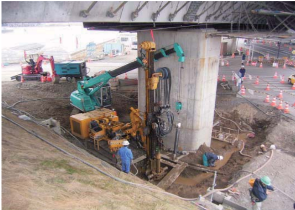
P1施工状況
