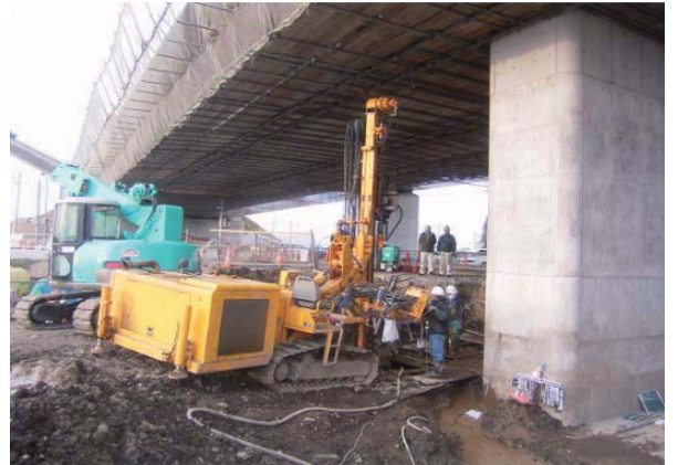
P2施工状況
