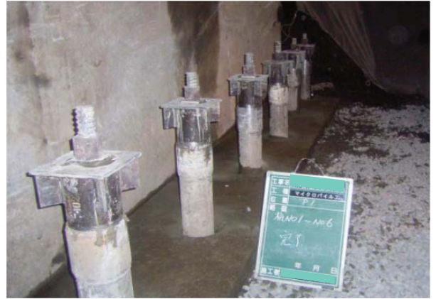
杭頭処理完了(P1)
