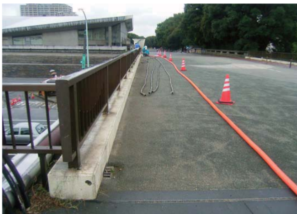
配管組立状況
