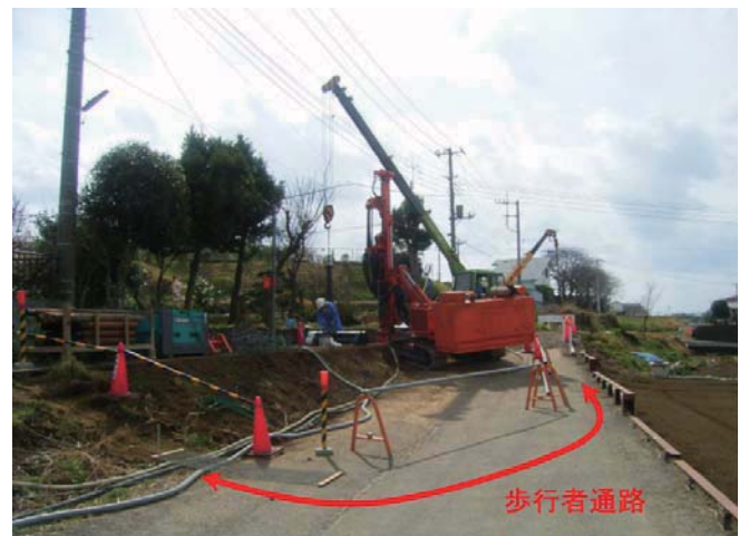
施工状況および歩行者通路の確保状況
