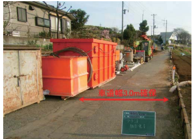
プラント設備および車道幅の確保状況
