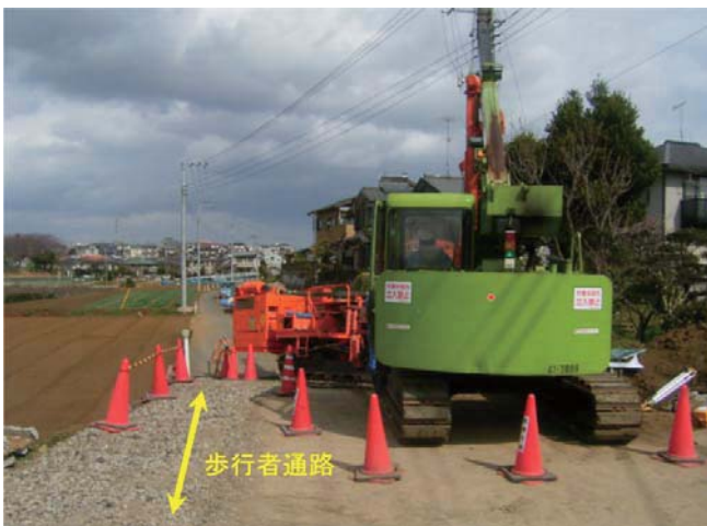
施工状況および歩行者通路の確保状況
