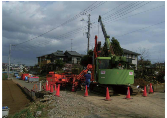
施工状況および現場全景
