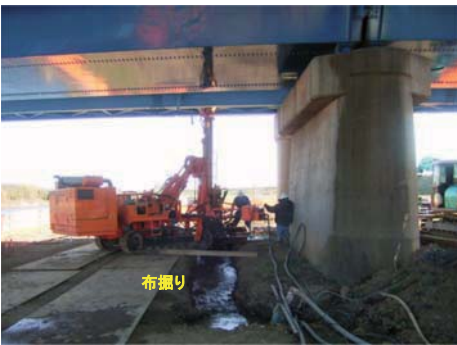
施工状況(P4橋脚)
