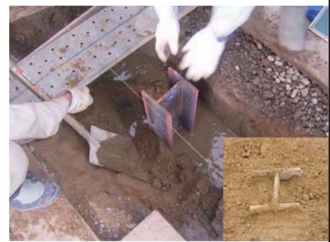
間詰め砂投入状況
