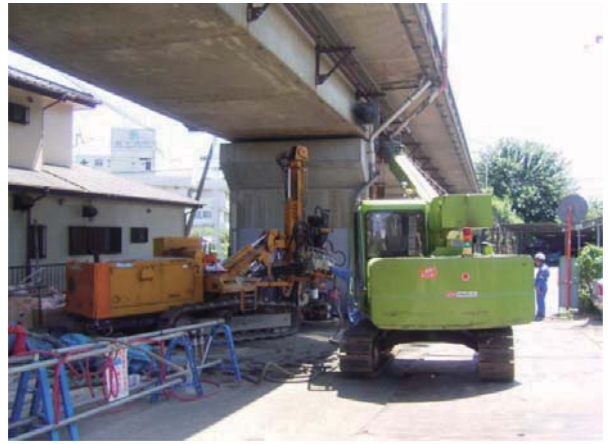
HMP施工状況(P3)
