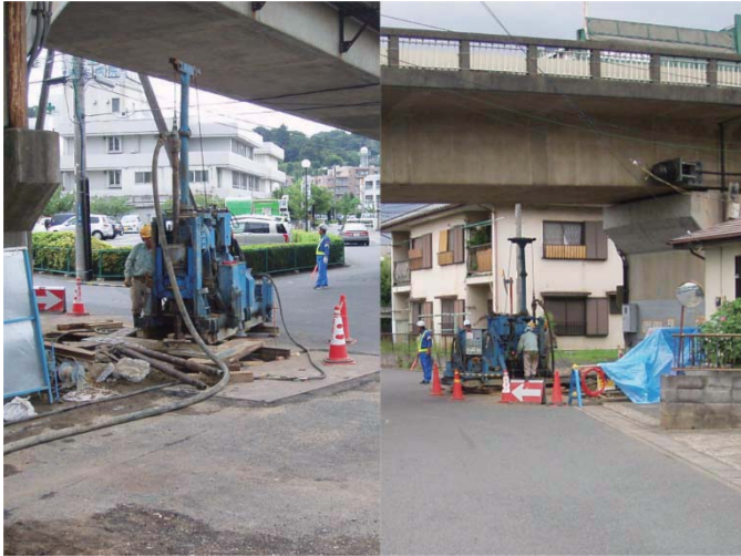
BH施工状況
