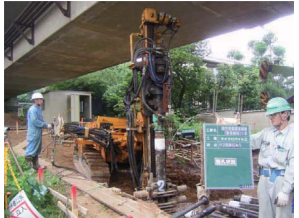
HMP施工状況(P2)
