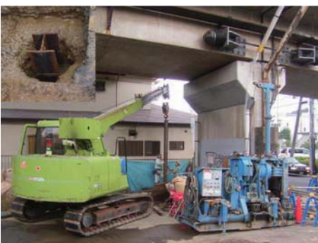
H鋼建込み状況
