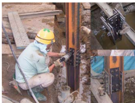
H鋼連結状況
