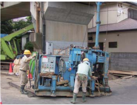
削孔機移動状況
