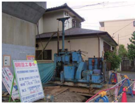
削孔機据付状況
