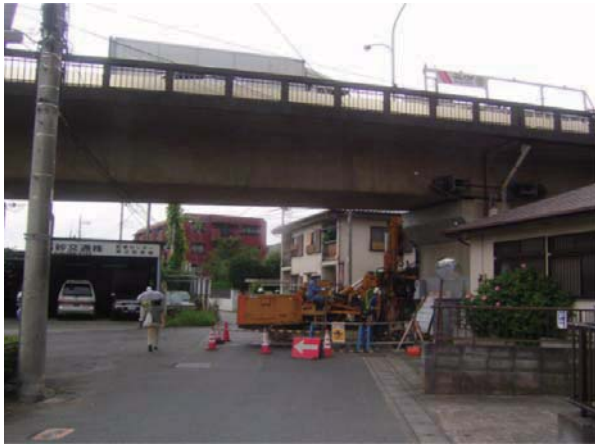
HMP施工状況(P3)
