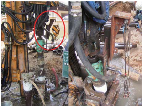
鋼管吊り込み治具
