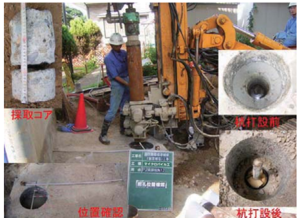
既設フーチング部先行削孔
