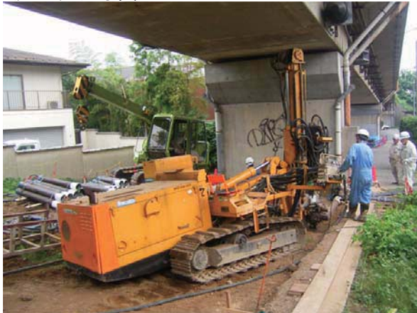
HMP施工状況(P2)
