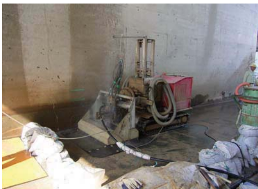
ウォータージェット削孔状況
