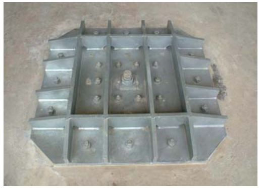
杭頭ブラケット設置状況
