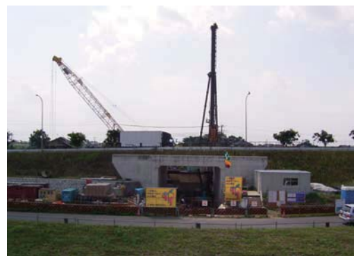
HMP(手前・カルバート内)と既製杭(奥)の施工状況
