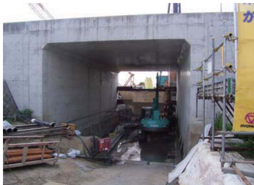
マイクロパイル打設状況
