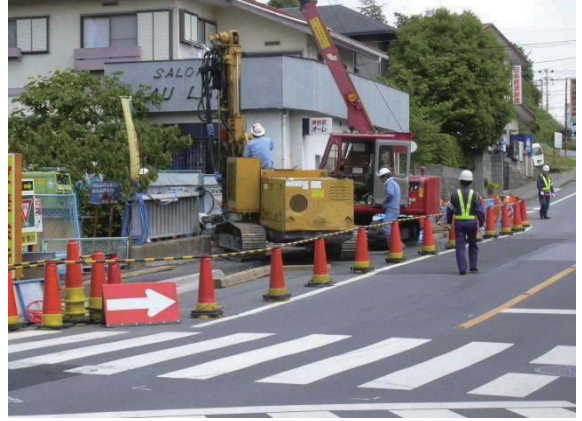
道路規制状況
