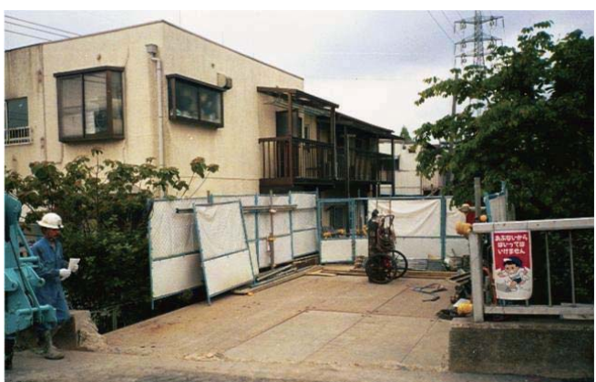
プラント設置ヤード
