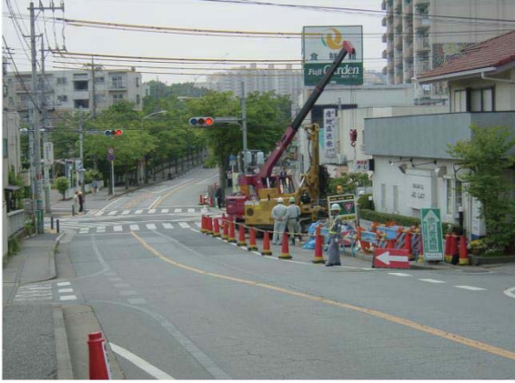
道路規制状況
