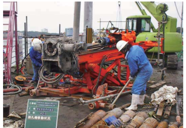
削孔機移動状況
