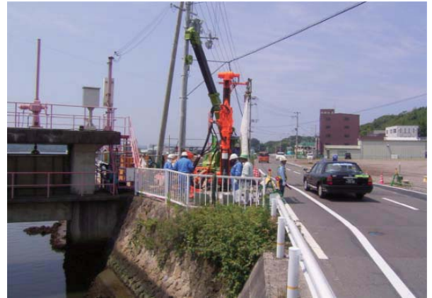
A2施工状況
