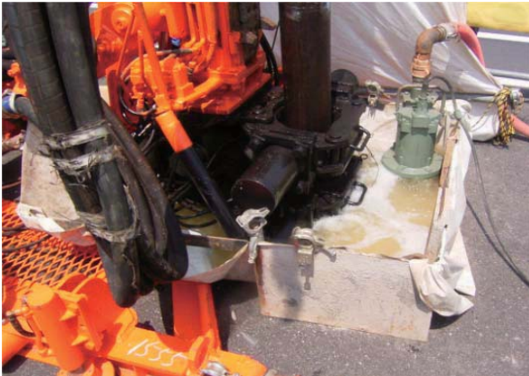
泥水等流出防止対策
