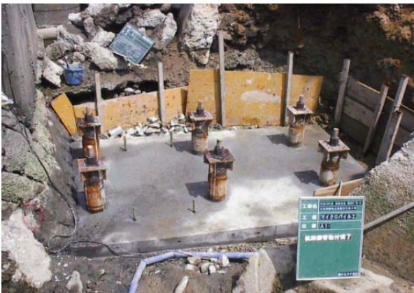
A1完成全景
