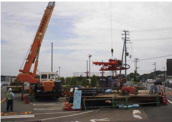
削孔機吊込み状況(A1)
