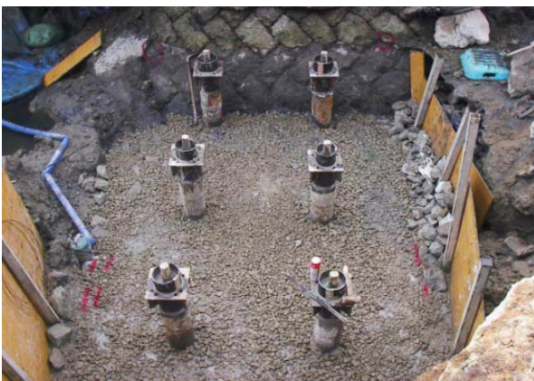
A1杭頭処理完了
