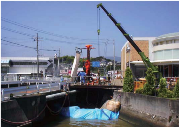
A1施工状況
