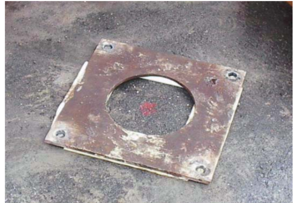
ずれ止め鉄板
