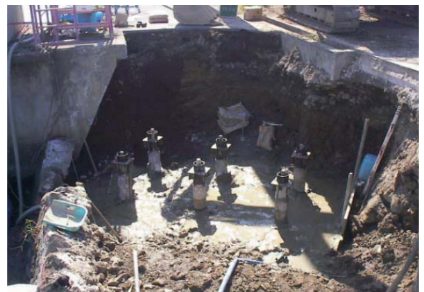
A2杭頭処理完了
