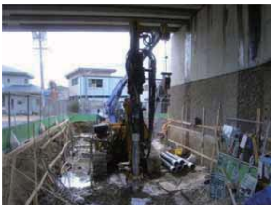
施工状況 (P12)
