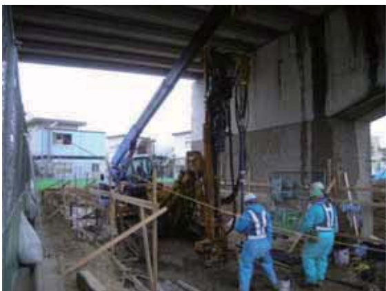
鉄筋挿入状況
