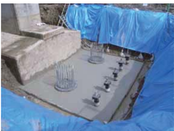
完成 (P8増設部)
