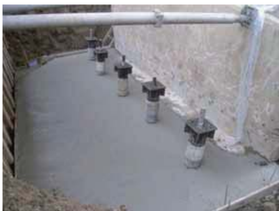
杭頭処理完了 (P8既設部)
