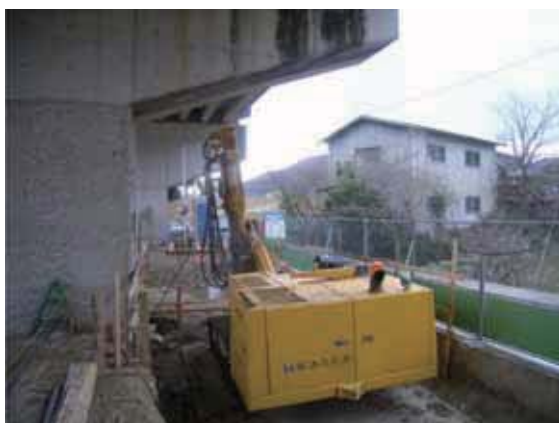
施工状況 (P8既設部)
