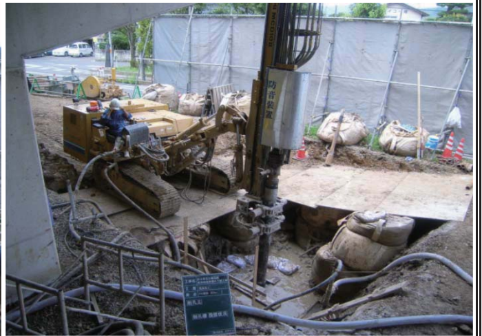
P0施工状況
