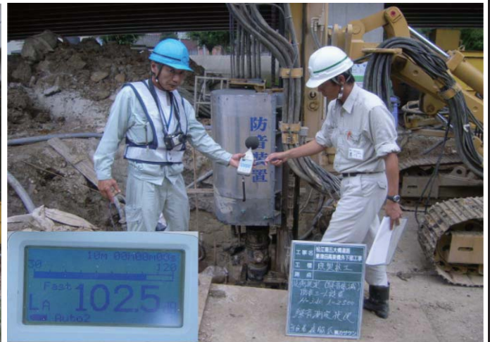
騒音レベル測定(削孔機直近)
