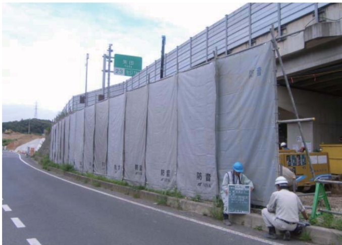
防音シート設置状況
