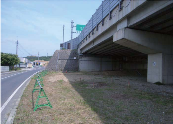
着手前現場全景
