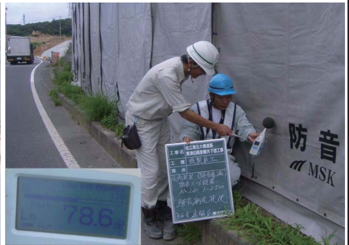
騒音レベル測定(敷地境界防音シート外側)
