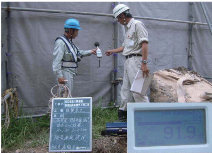
騒音レベル測定(敷地境界防音シート内側)
