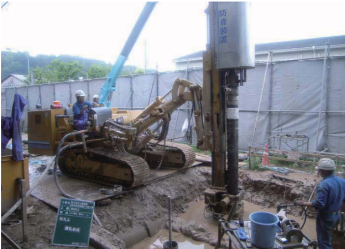
A1施工状況
