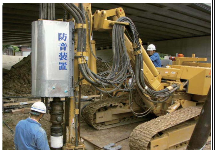
防音装置取付状況
