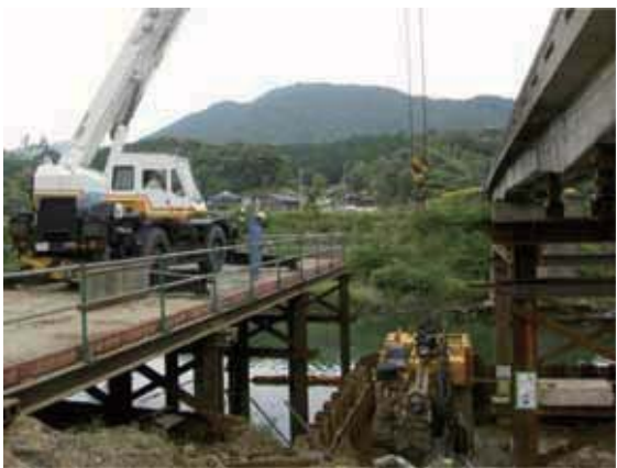
削孔機搬入状況
