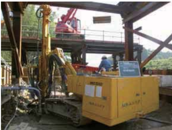
施工状況(資材吊込み)
