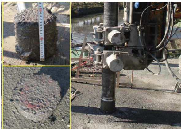
アスファルト舗装先行削孔
