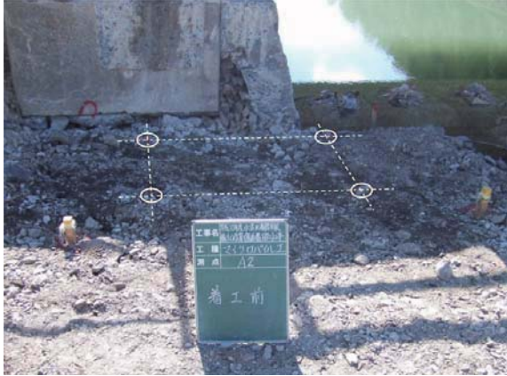
着工前全景(A2橋台)
