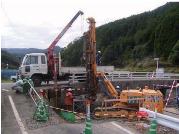
施工状況(A2橋台)
