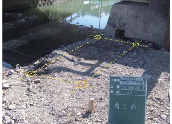
着工前全景(A1橋台)
