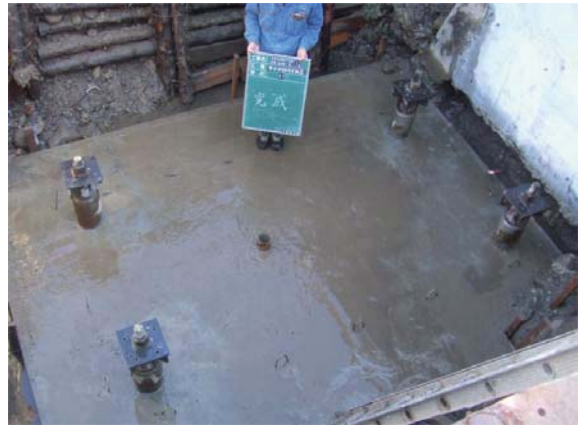
完成時全景(A1橋台)
