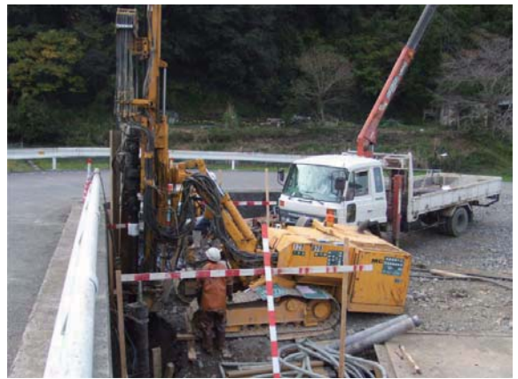
施工状況(A1橋台)
