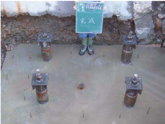
完成時全景(A2橋台)
