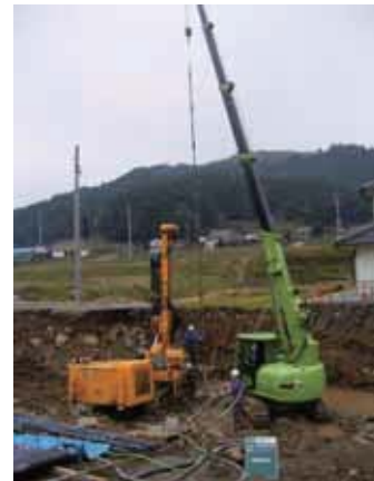
鉄筋挿入状況
