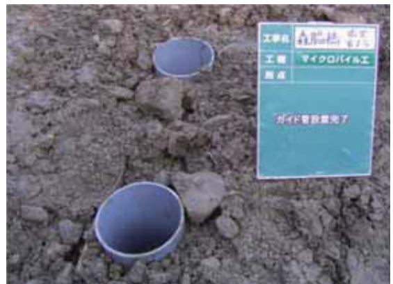
ガイド管設置完了
