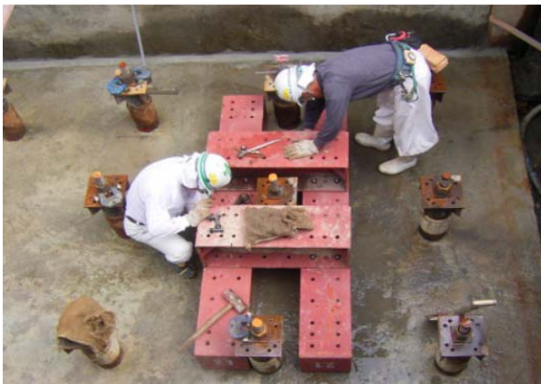
載荷装置組立状況
