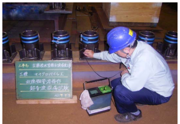
杭頭溶接部超音波探傷試験状況
