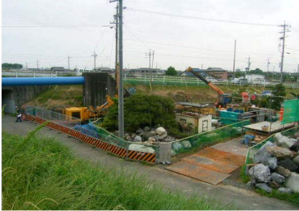
A1現場全景
