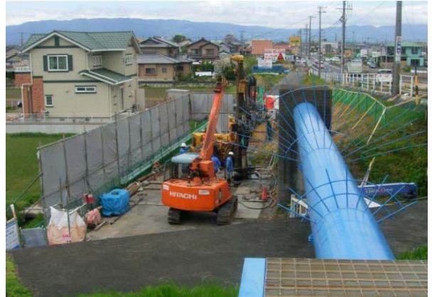
A2現場全景
