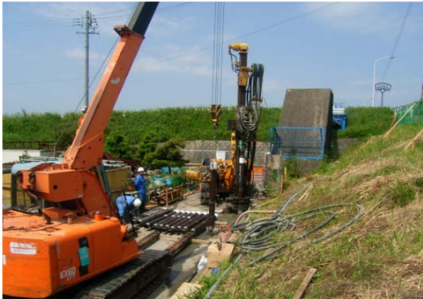
A1施工状況
