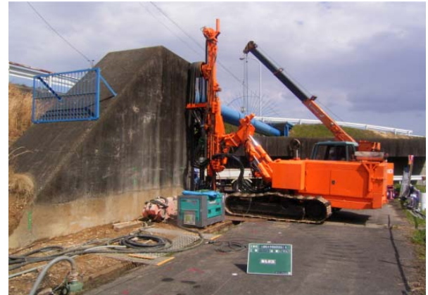
A2施工状況
