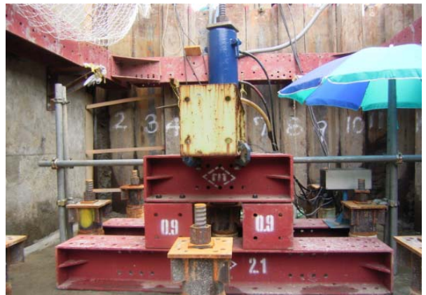
引抜き載荷試験状況
