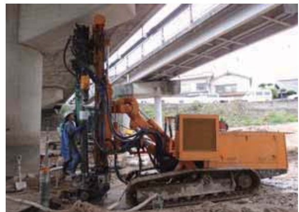
施工状況(中央車道橋P2)
