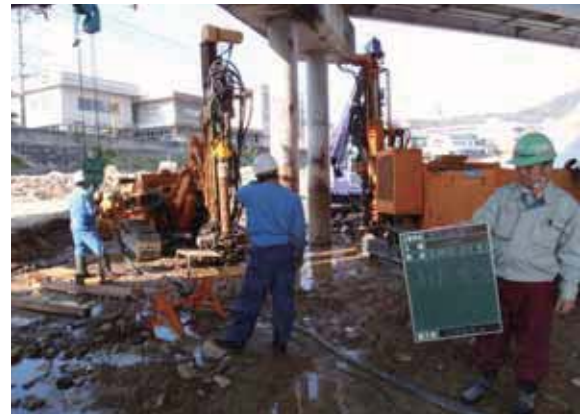
施工状況(下流歩道橋P2)
