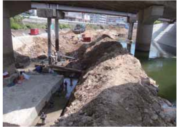
河川締切状況
