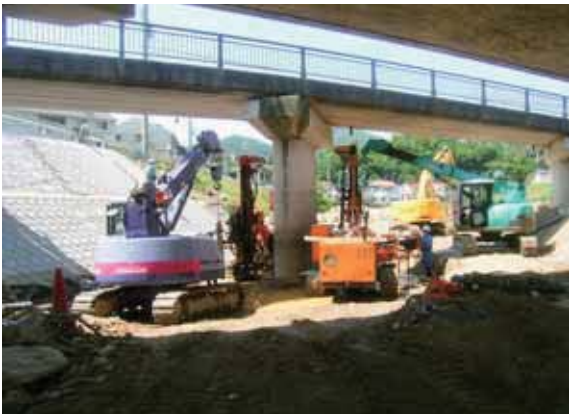
施工状況(上流歩道橋P2)
