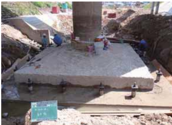
施工完了(中央車道橋P1)
