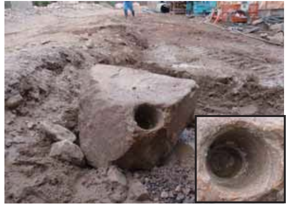
削孔途中で回収撤去した転石
