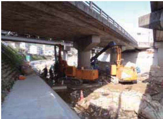
施工状況(中央車道橋P1)
