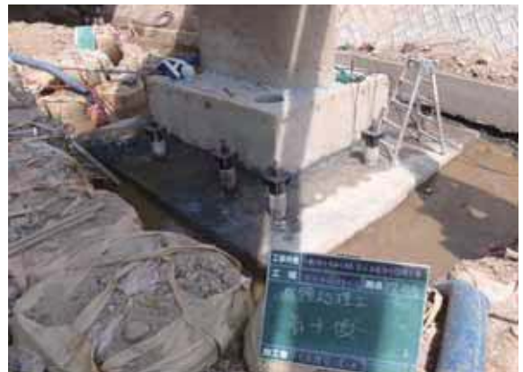
施工完了(上流歩道橋P2)
