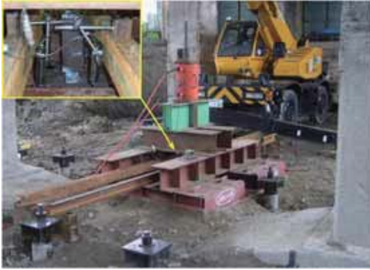
載荷試験装置
