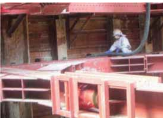
横矢板背面グラウト打設状況
