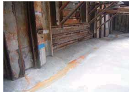
横矢板下部コンクリート打設
