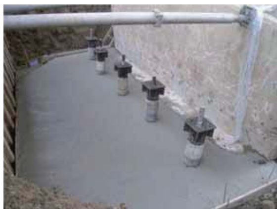
杭頭処理完了 (P8既設部)
