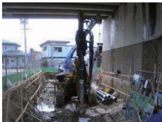
施工状況 (P12)
