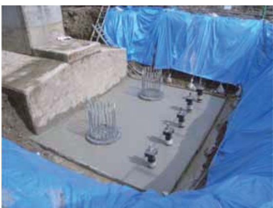
完成 (P8増設部)
