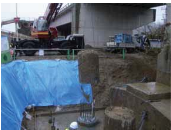
杭頭処理(ベント杭)
