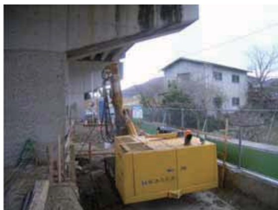
施工状況 (P8既設部)
