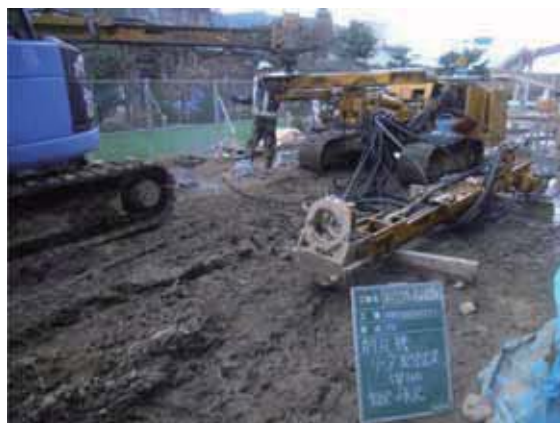
リーダー交換状況
