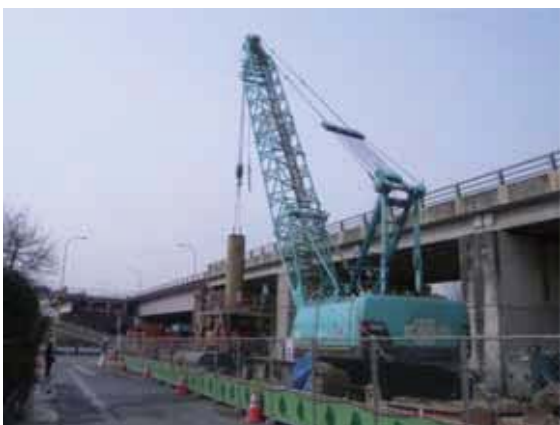
ベント杭施工状況
