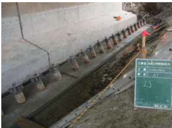
A1完成全景
