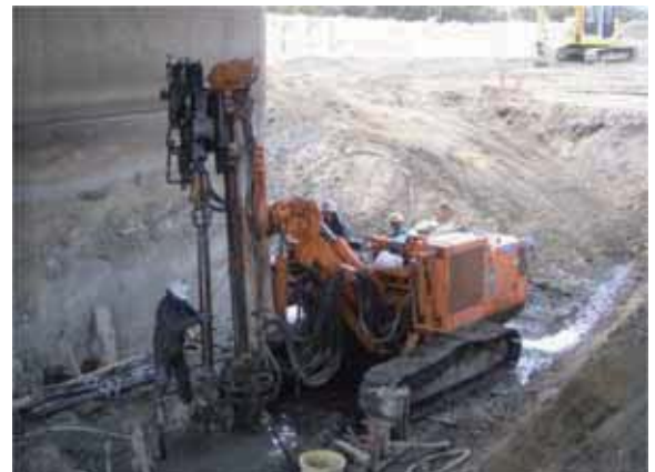
P1施工状況
