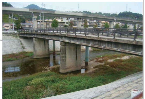
工事着手前全景
