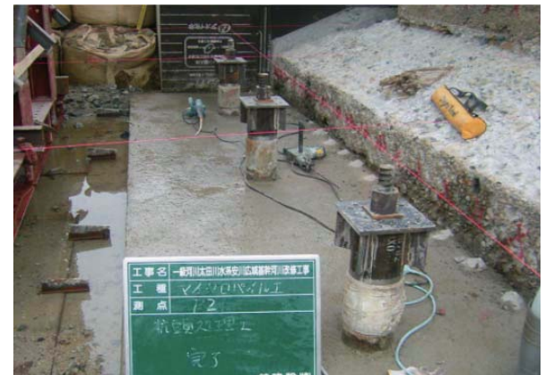
杭頭処理完了
