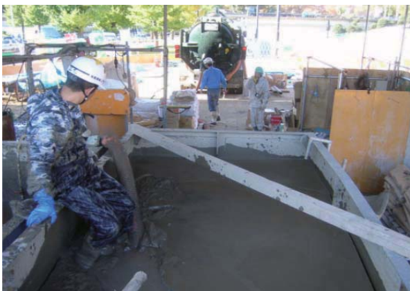
産廃処理(泥水)
