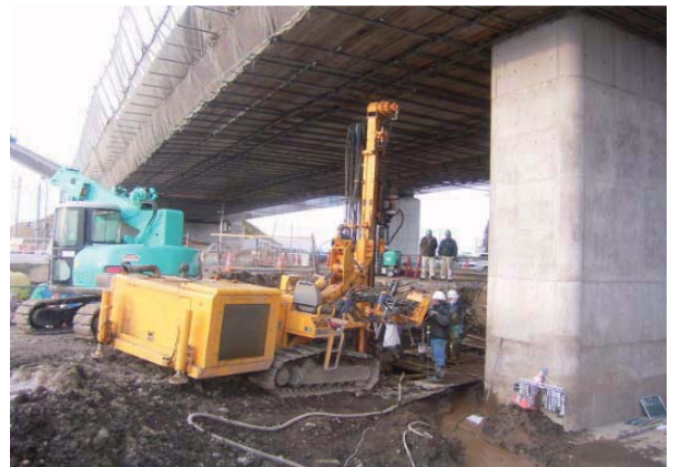
P2施工状況
