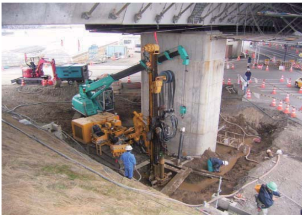
P1施工状況
