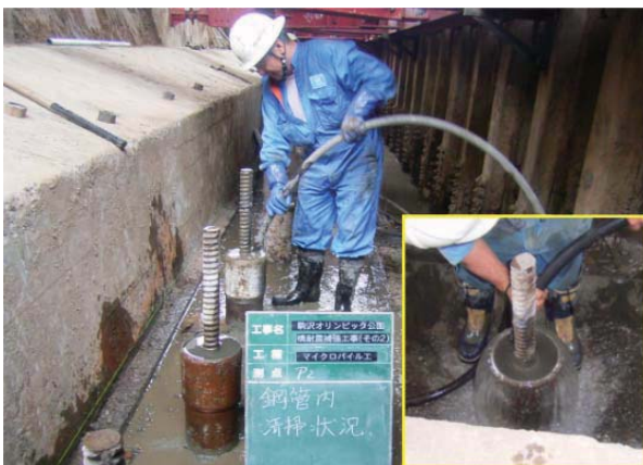
杭頭清掃状況
