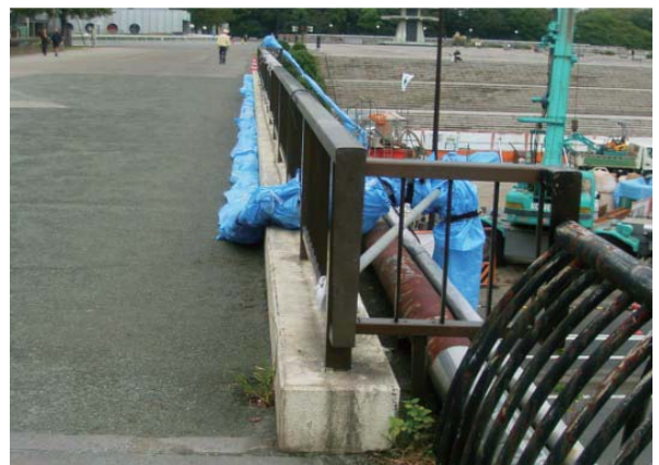
配管シート養生
