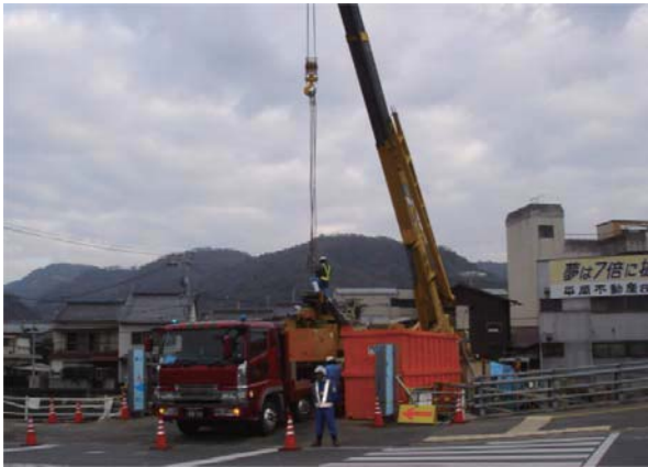
削孔機搬入状況
