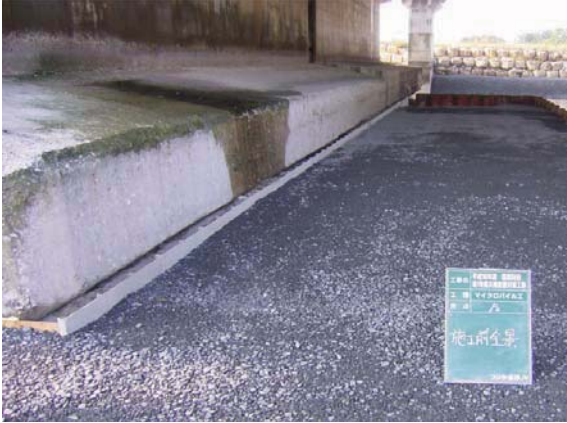
着工前全景 (P2橋脚)
