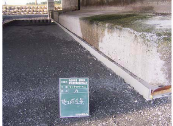
着工前全景 (P1橋脚)
