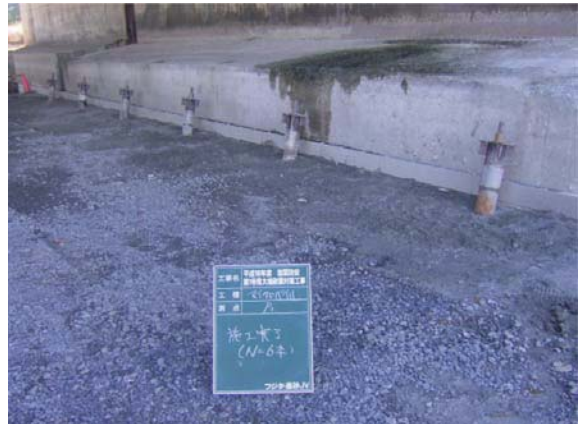
完成時全景 (P1橋脚)
