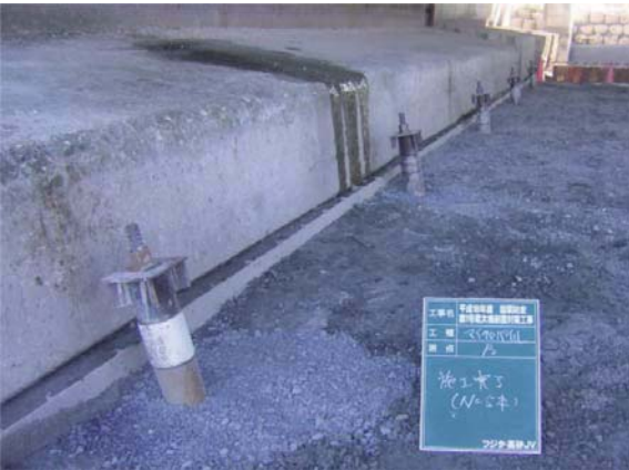
完成時全景 (P2橋脚)
