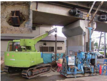
H鋼建込み状況
