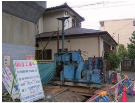
削孔機据付状況
