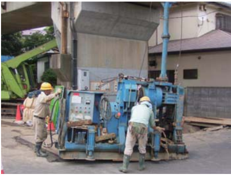
削孔機移動状況
