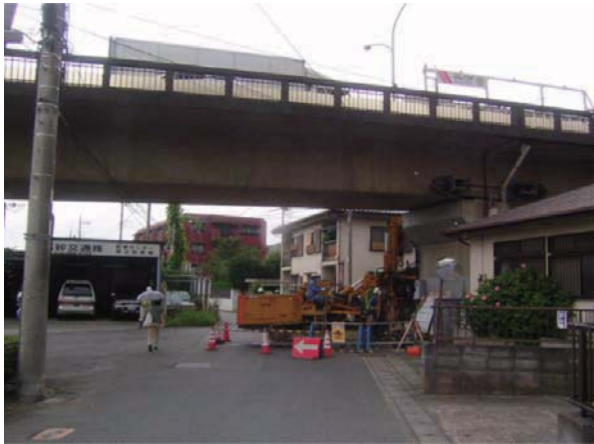
HMP施工状況(P3)
