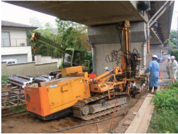
HMP施工状況(P2)
