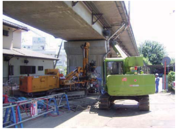
HMP施工状況(P3)
