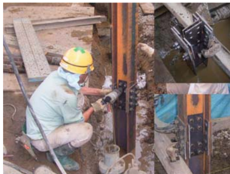
H鋼連結状況
