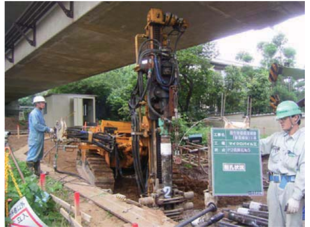
HMP施工状況(P2)
