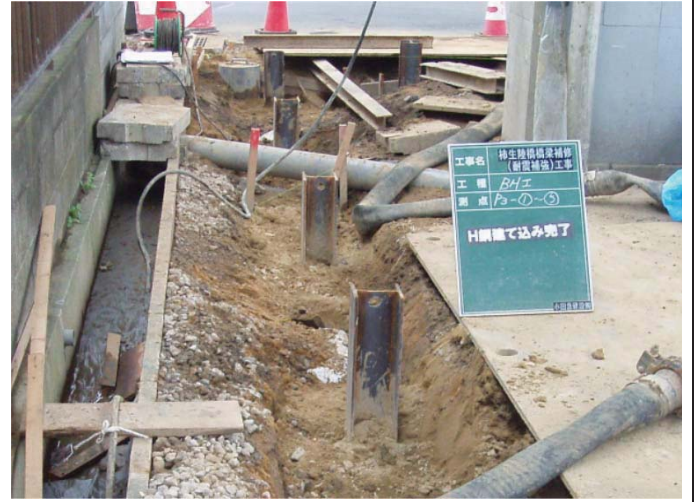
BH完成全景
