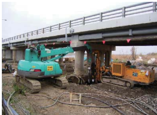
マイクロパイル施工状況
