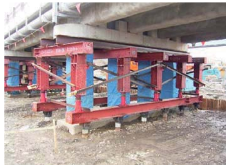
仮受け支保工
