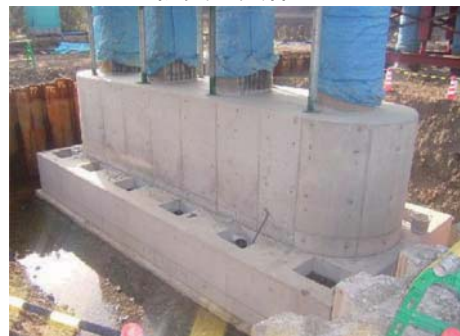
新設フーチング完成
