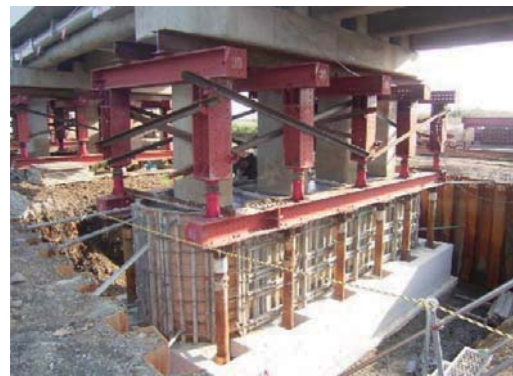
仮受け支保工および橋脚補強
