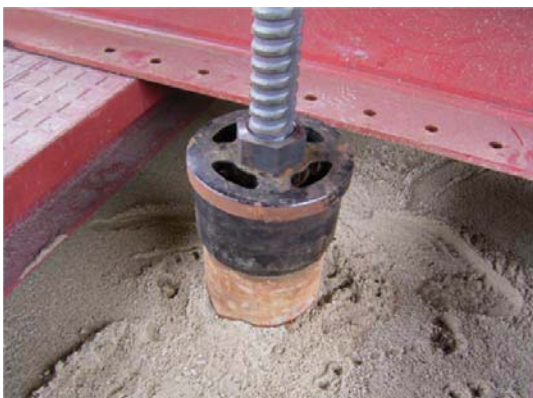
載荷用杭頭部材
