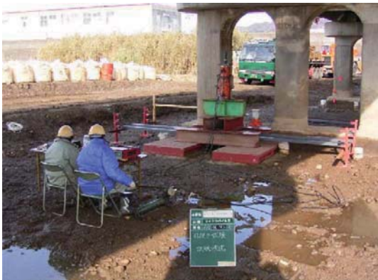
載荷試験状況
