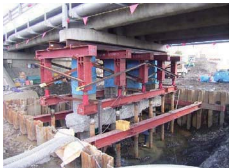
仮受け支保工および掘削時全景
