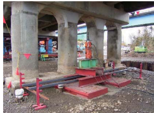
載荷装置全景
