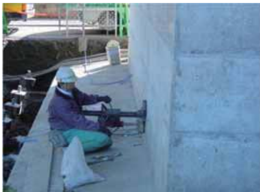
アンカー用削孔状況
