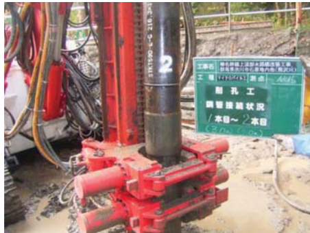
鋼管接続状況
