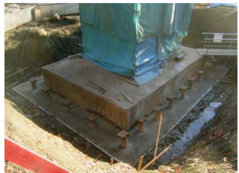
STマイクロパイル完成
