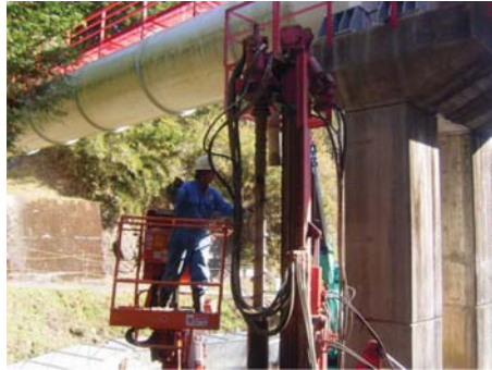
オーガ接続状況
