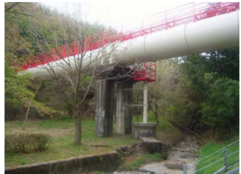
現場全景(着工前)
