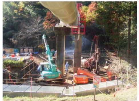
STマイクロパイル施工状況
