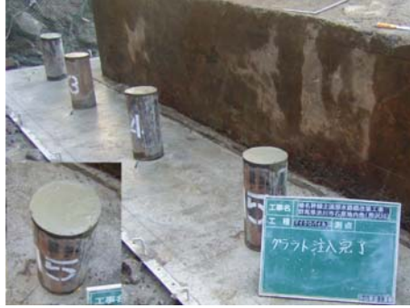
杭頭部グラウト充填完了
