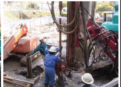
注入用ロッド接続状況
