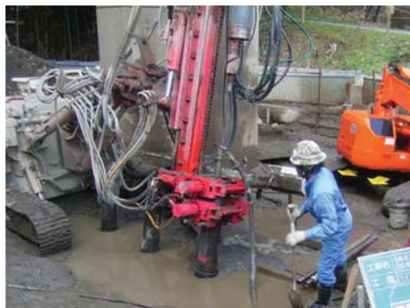
グラウト注入(段階加圧)
