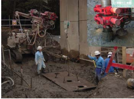
敷鉄板・ガイド管設置状況
