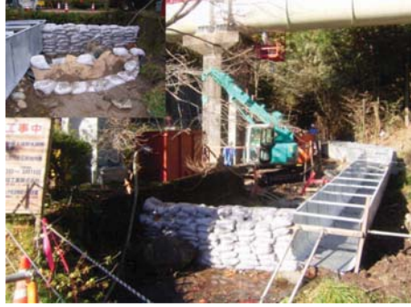
仮設(河川切替え・締切り)
