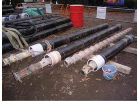
削孔準備(鋼管・オーガ)
