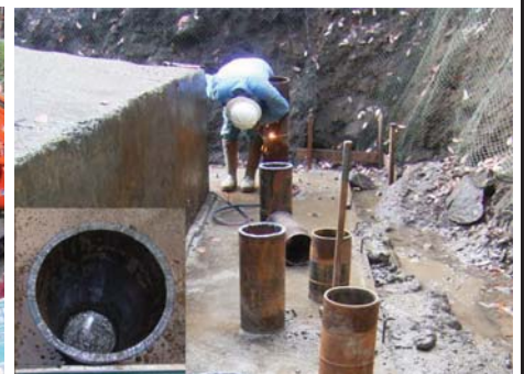
杭頭部鋼管切断状況
