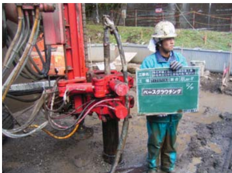
グラウト注入(ベースグラウチング)
