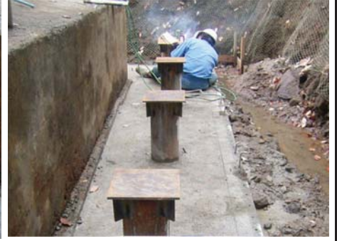
杭頭部材取付状況
