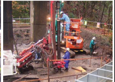
鋼管接続状況
