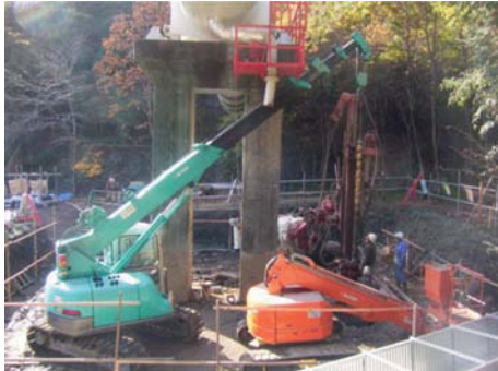
鋼管・オーガ吊り込み状況
