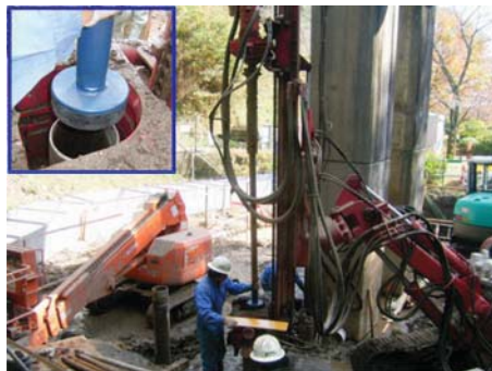
パッカー挿入状況
