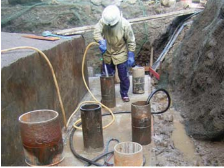
杭頭部清掃状況
