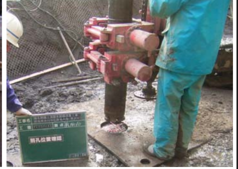
削孔位置確認
