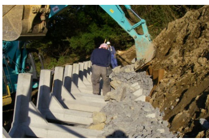
② 胴込・裏込材投入状況
