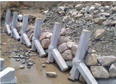
① 1段目据付状況
