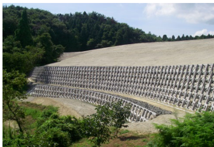
④ 完了全景
